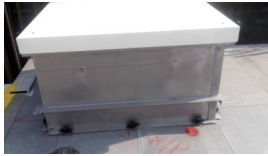
Thi công thang cửa sập ở AL form (Cốp pha nhôm)
