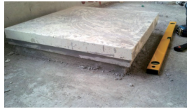
Đổ bê tông
