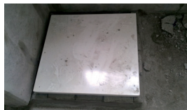
Lắp cửa sập và hoàn thiện (Chống thấm)
